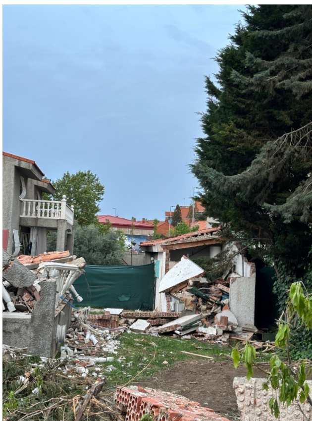
2. Escombros de la vivienda derribada el 20 de abril (estructura de ladrillo, no chabola ni infravivienda).
